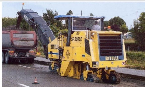
fig. 01 – Operazioni di scarifica in sede stradale
