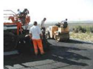
fig. 01 – Operazioni di finitura manto stradale
