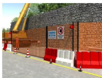
BARRIERE STRADALI "NEW JERSEY" (particolare di una delimitazione di cantiere)
